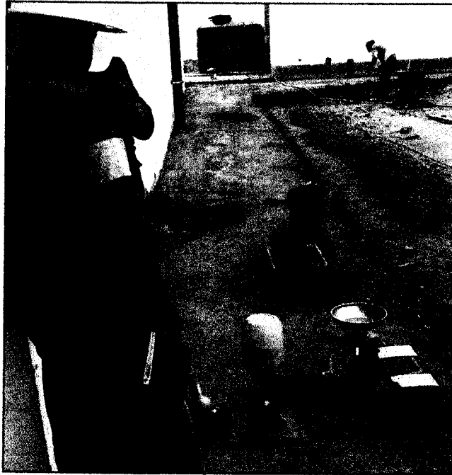
Prueba de compactación en el patio de desembarque
