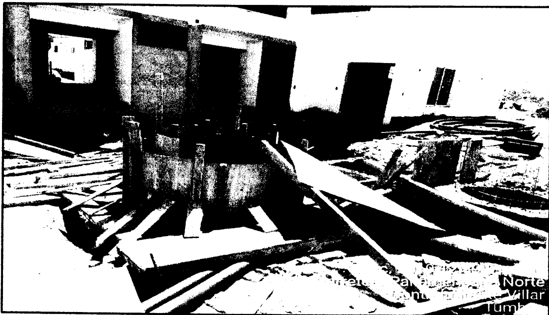
Imagen N°8 Se observa en la imagen realizando trabajos de encofrado, de los buzones de drenaje fluvial del DPA-Acapulco.
