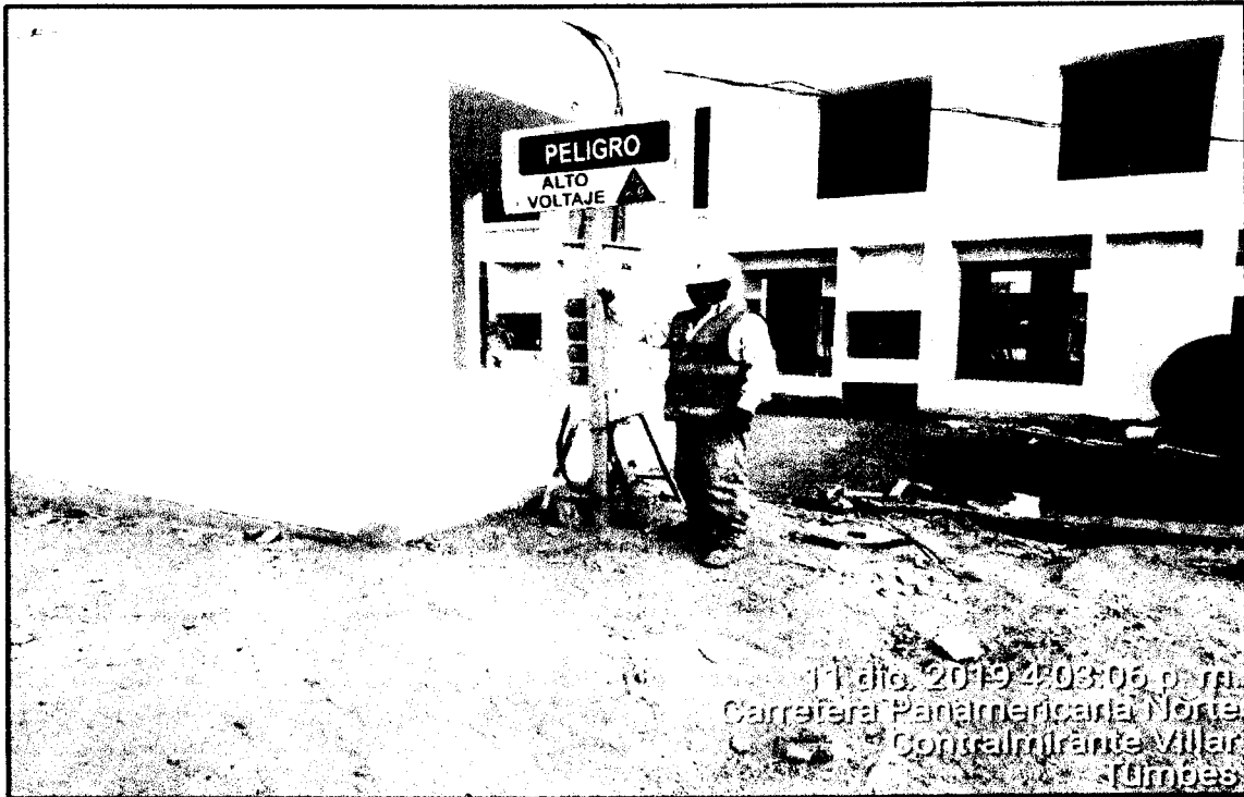
Imagen N°12 Se observa en la imagen que se ha señalado el tablero eléctrico para evitar riesgos de electrocución
