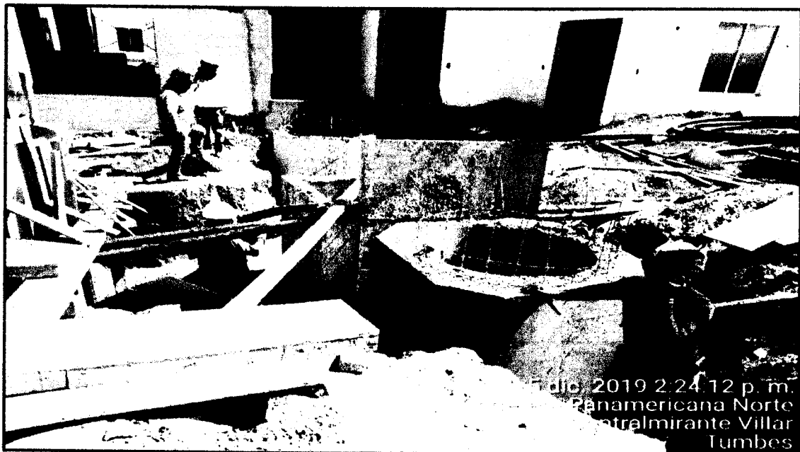
Imagen N° 10 Se observa en la imagen a los trabajadores haciendo trabajos de desenformado de los buzones de drenaje fluvial del agua del DPA-Acapulco. Con sus EPPs completos
