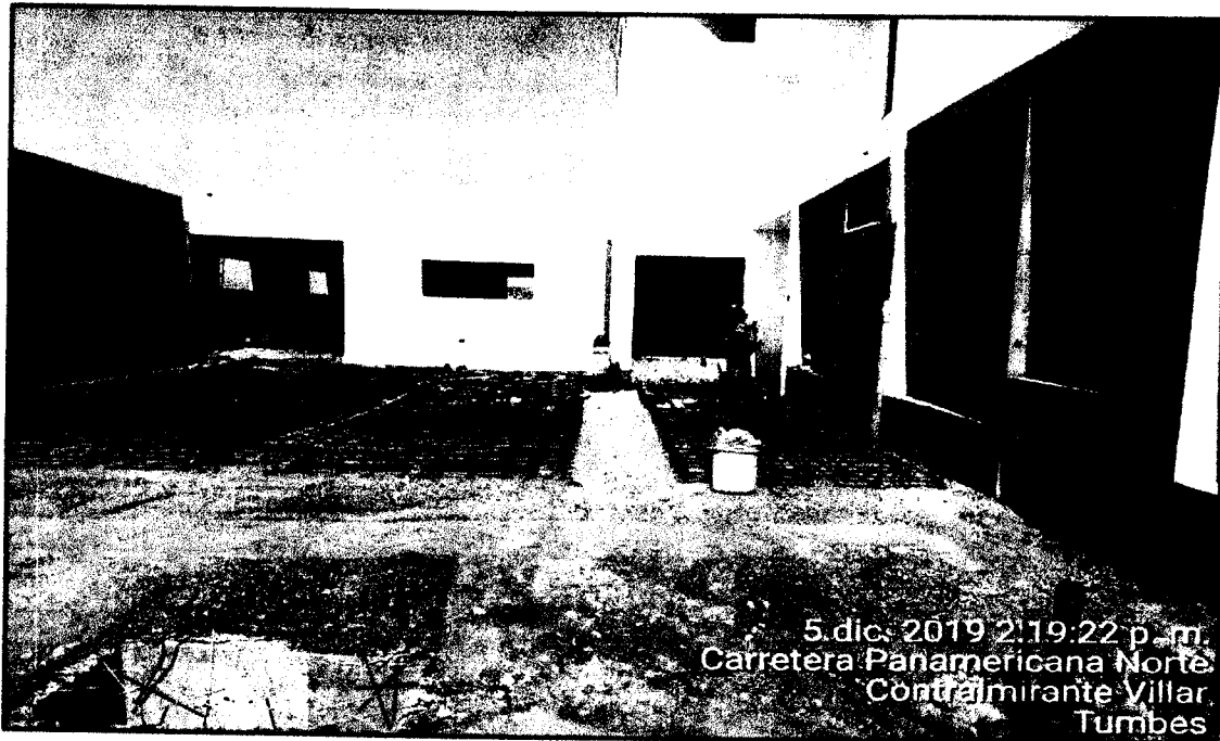
Imagen N°3 La imagen muestra que se está realizando trabajos de colocación de acero corrugado en el pavimento del patio de desembarque de productos hidrobiológicos.
