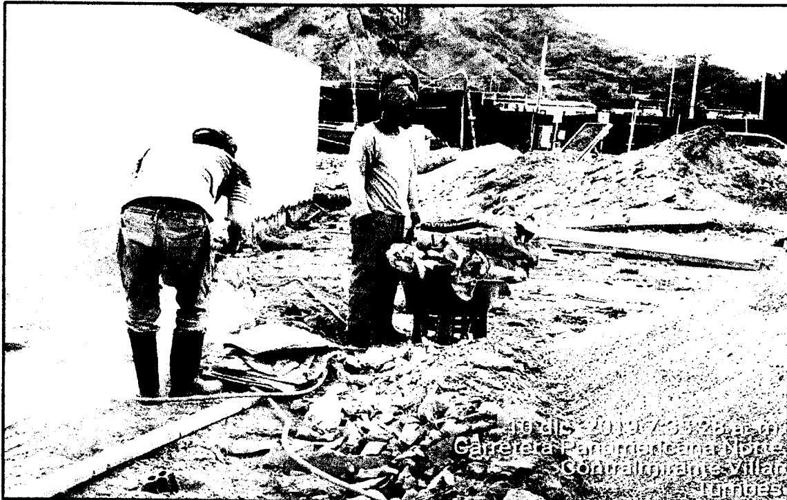
Imagen N°3 A la vista de la imagen se aprecia a los trabajadores realizando limpieza de la obra de los residuos sólidos.
