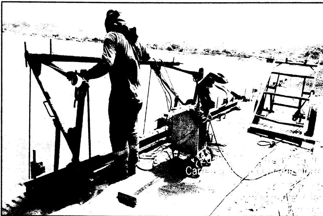
Imagen N°17 Se observa en la imagen a los trabajadores haciendo su trabajo de soldadura eléctrica usando la máquina de soldar modelo HOBAR 250 - HD, conservando el orden y limpieza para cuidar el medio ambiente.
