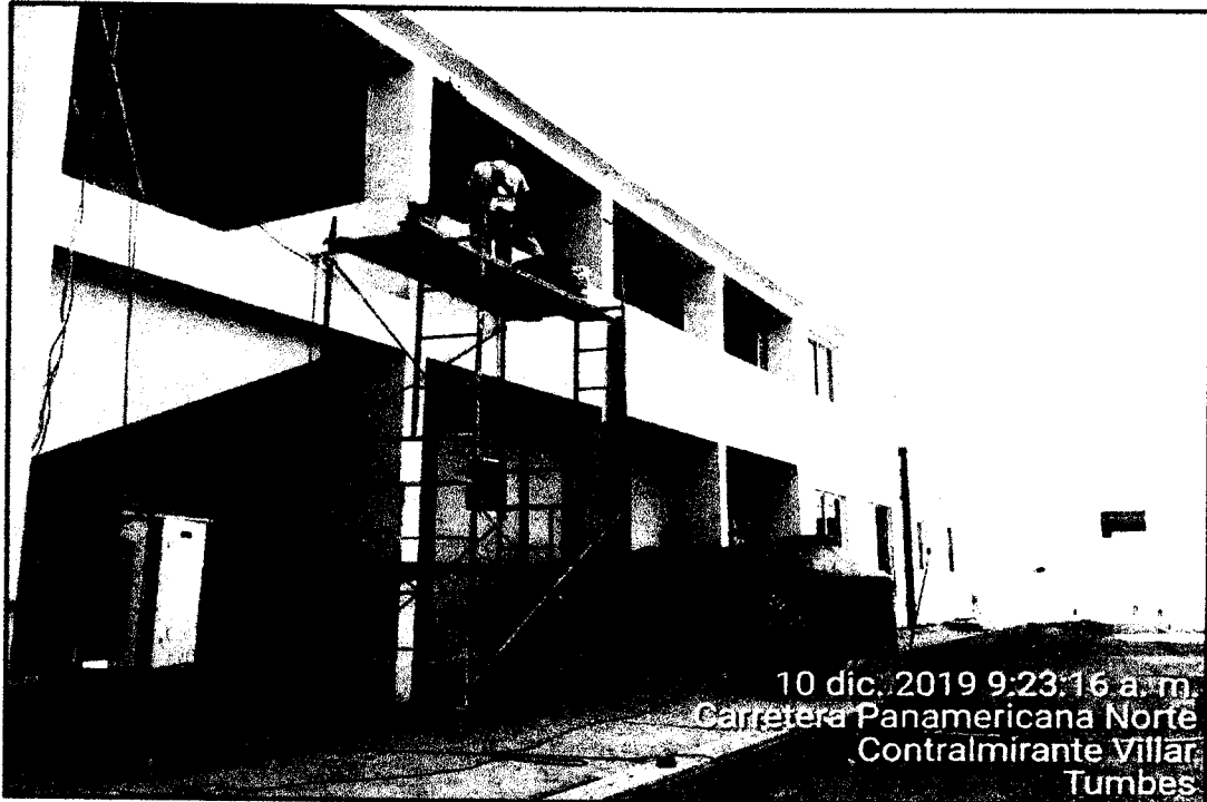
Imagen N°7 En la imagen se aprecia la ejecución de remates de tarrajeo, en el edificio de administración, con el armando de andamios y equipo de seguridad y EPP's.
