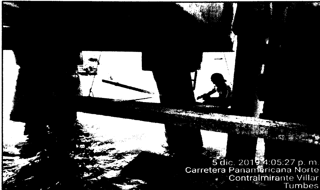
Imagen N°17 La imagen muestra los trabajos que se viene haciendo de resane a los pilotes en el cabezo del muelle.
