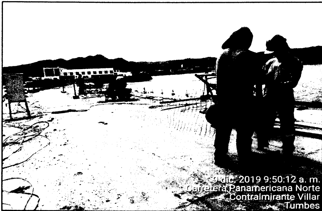
Imagen N°22 En la imagen se muestra que los trabajadores están haciendo señalización con malla de seguridad para delimitar el área de trabajos de soldadura de acuerdo a la G050 de Construcción Civil
