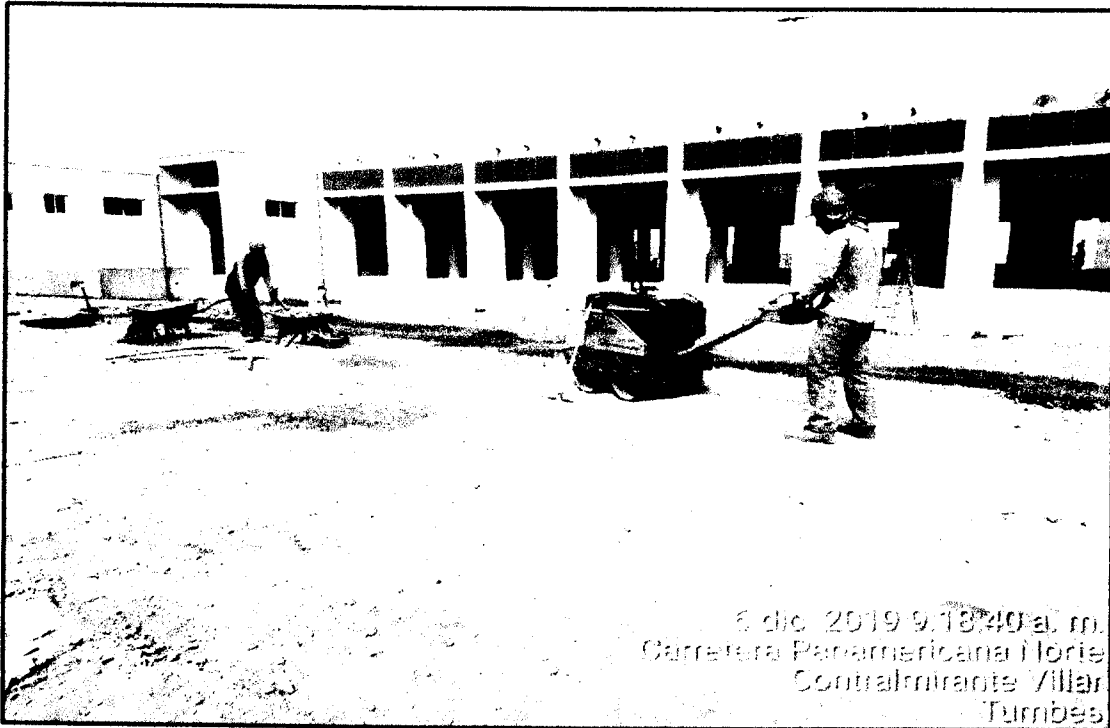
Imagen N° 11 Se observa en la imagen a los trabajadores haciendo trabajos de compactación en el patio de maniobras, del DPA-Acapulco. Con sus EPPs completos.
