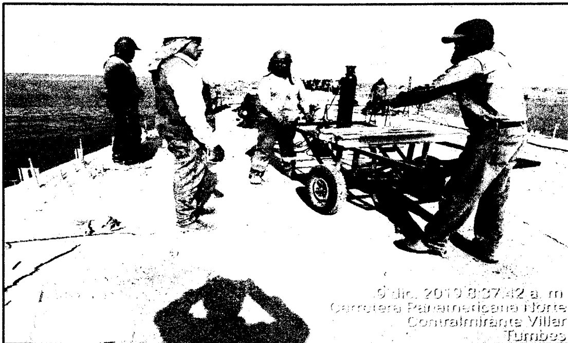
Imagen N°21 Se observa en la imagen a los trabajadores utilizando una carreta para transportar los rieles evitando riesgos de sobre esfuerzos al movilizar materiales pesados como los rieles metálicos.
