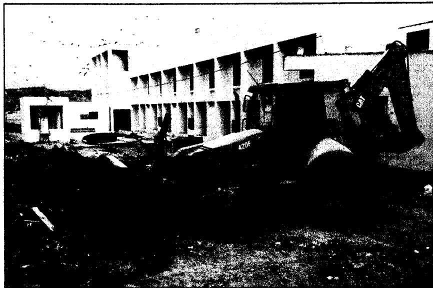
Acarreo del material de excavación de los cimientos del cerco perimétrico
