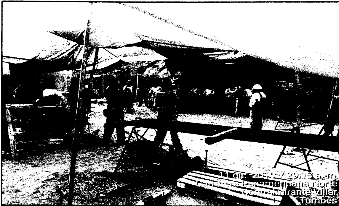
Imagen N°13 Se observa en la imagen que se está realizándola charla de 10 minutos, antes del inicio de las tareas.
