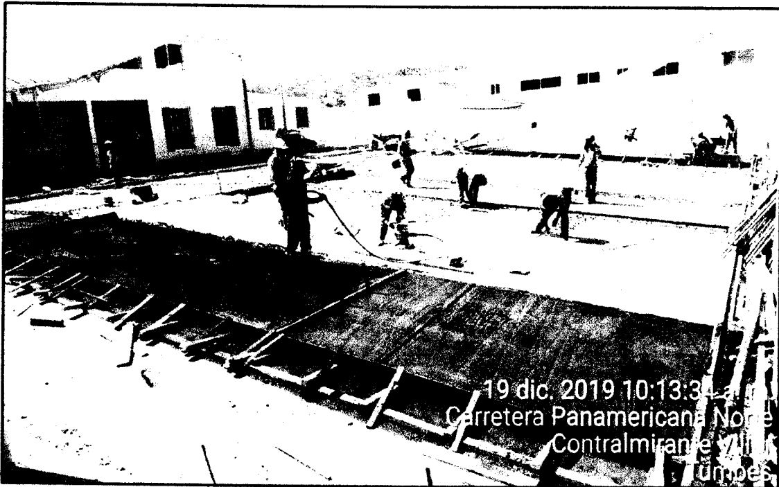
Imagen N° 12 Se observa en la imagen a los trabajadores albañiles haciendo trabajos de vaciado de concreto en el patio de maniobras del DPA-Acapulco.
