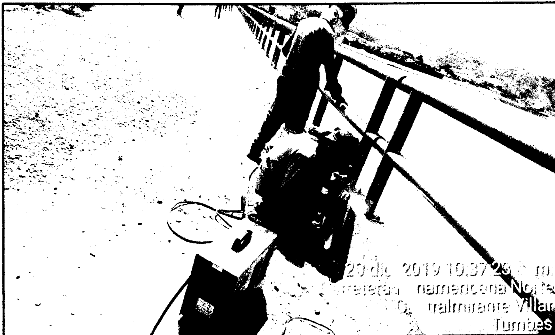
Imagen N°15 Se observa en la imagen a los trabajadores haciendo su trabajo de soldadura en la baranda en el muelle usando la máquina de soldar modelo STICKMATE LX 235 AC
