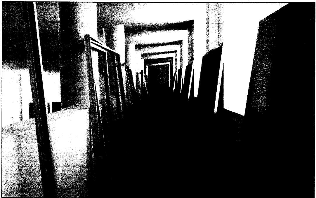
Ventanas de aluminio y malla rashel en el edificio de Tareas Previas
